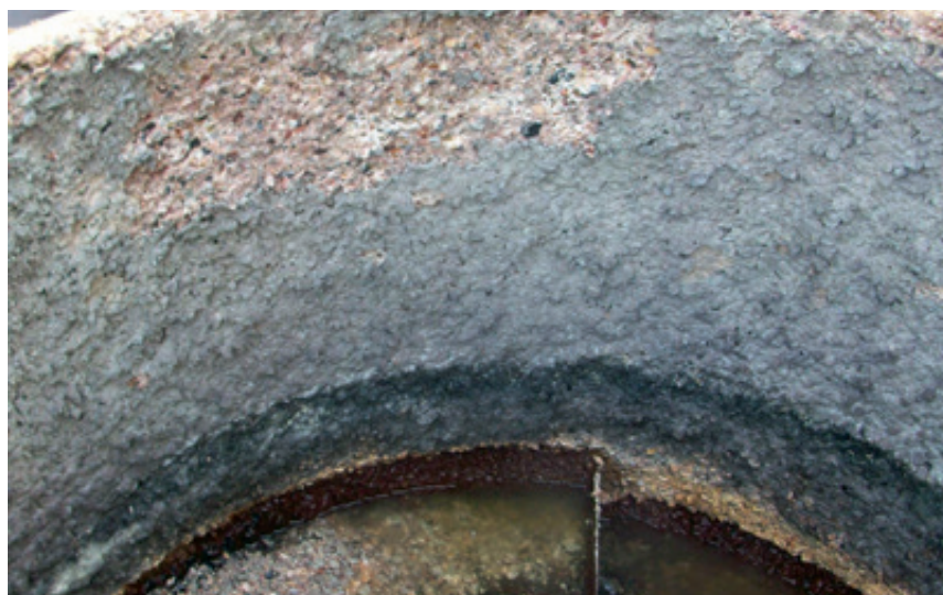
Abb. 6: Durch MIC verursachte Betonzersetzung im Abwassersystem eines Lebensmittelverarbeitenden Betriebs
