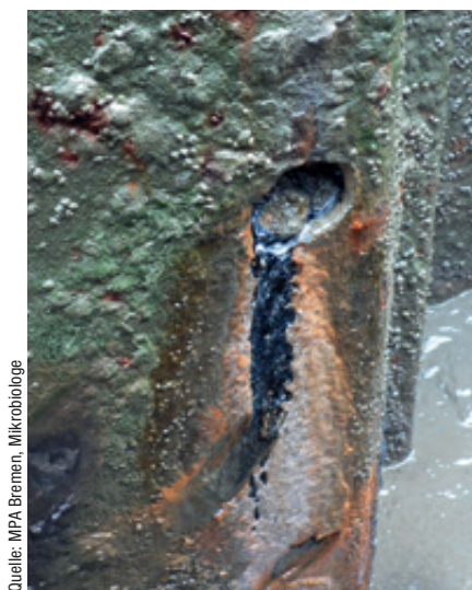
Abb. 5: Durch MIC von der Landseite verursachtes Loch in einer metallischen Spundwand
